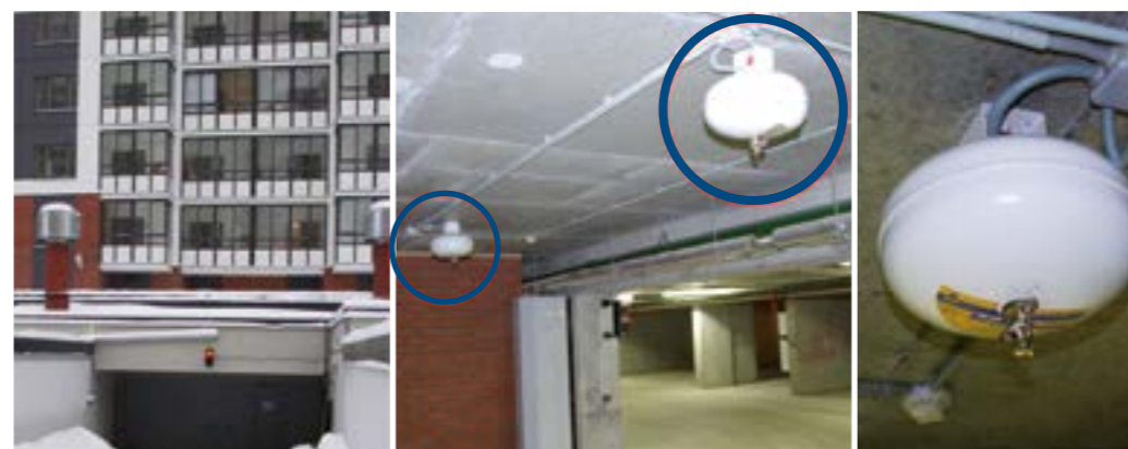
Подземная автостоянка в жилом доме. г. Санкт-Петербург
